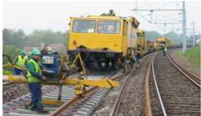
Longs Rails soudés sur traverses béton
